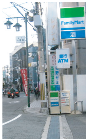
移設が望まれる電柱
