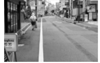
(写真上) センターラインが無くなった車道
