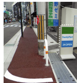
新しくなった歩道
